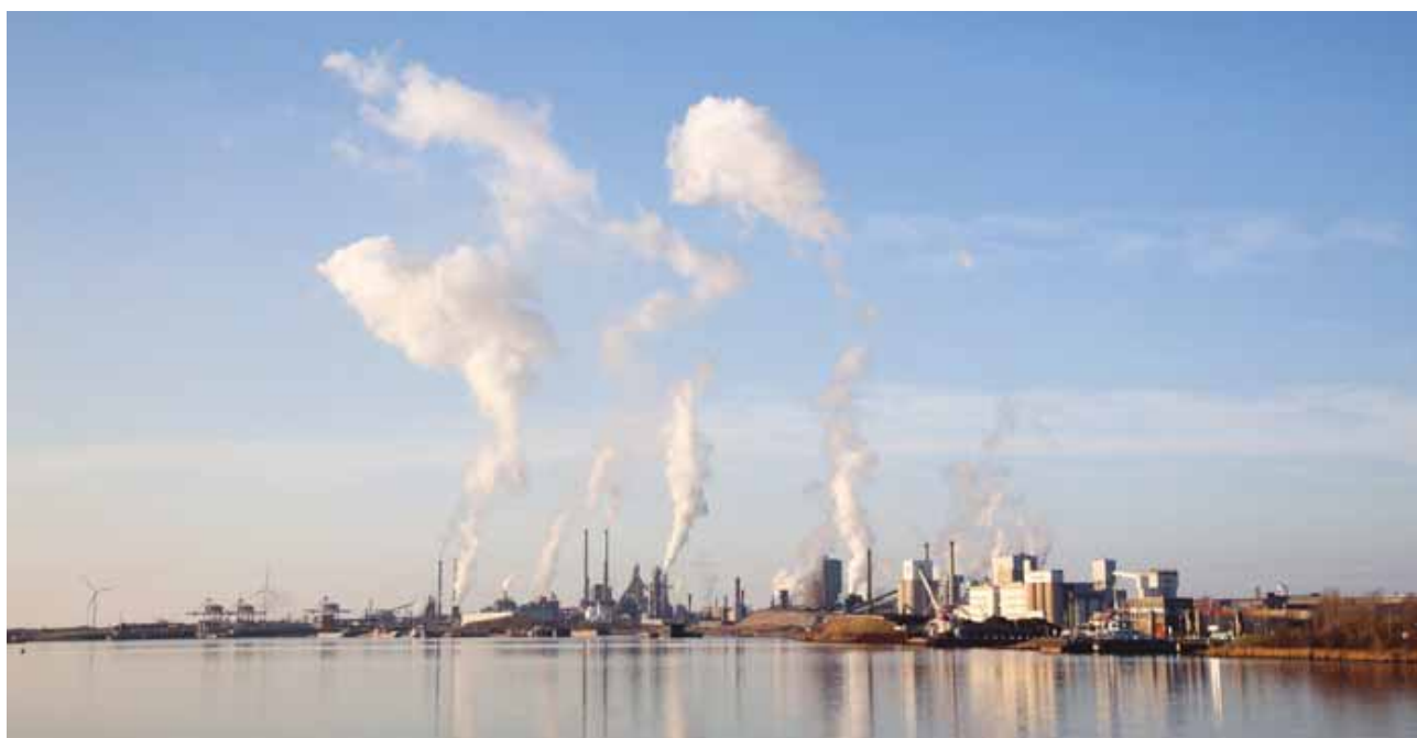
Tata Steel streeft in IJmuiden naar meer energie-efficiëntie in de warmbandwalserij
